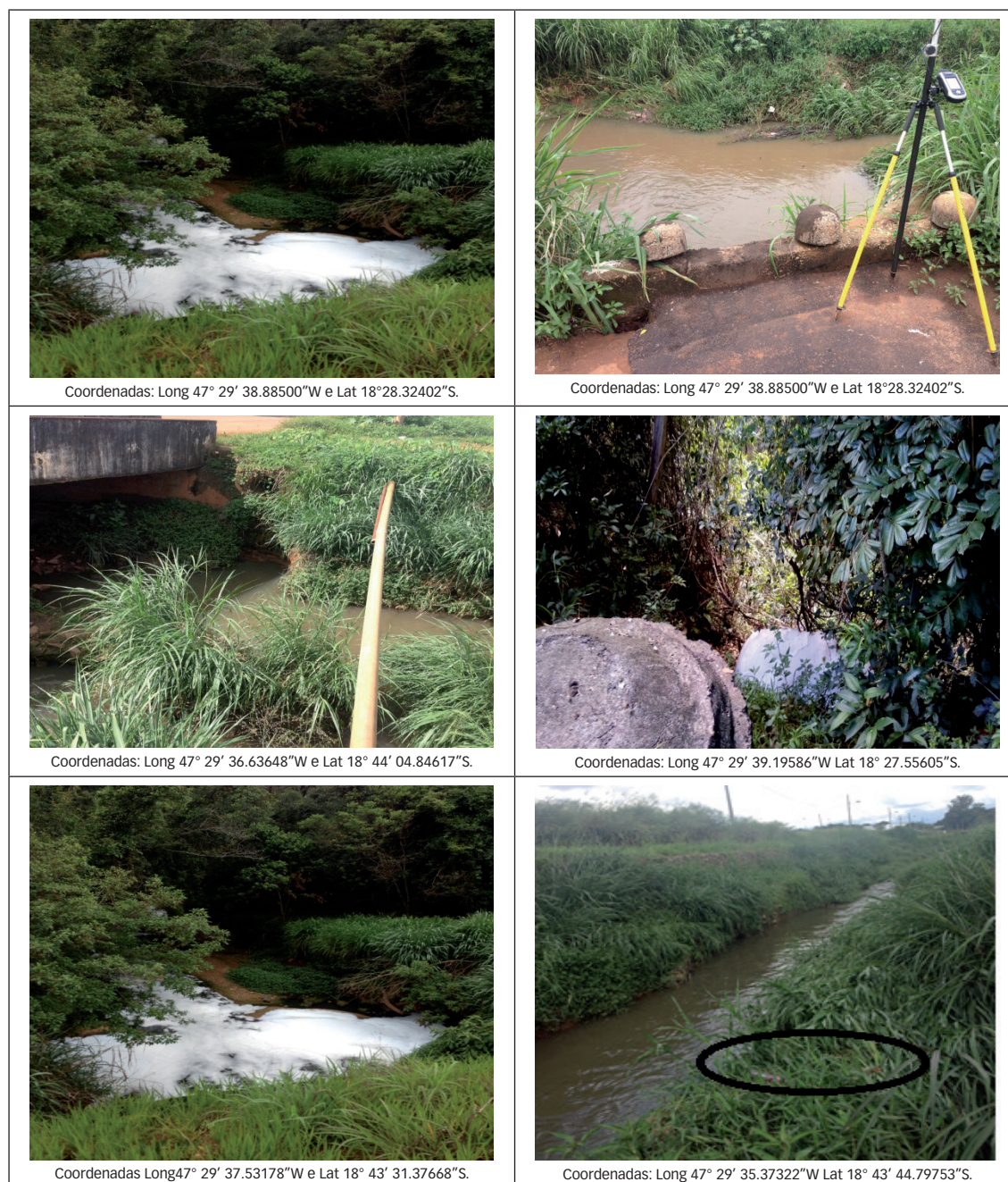
Figura 5: Pontos identificados de lançamento indevido de esgoto ao longo do Córrego Mumbuca
