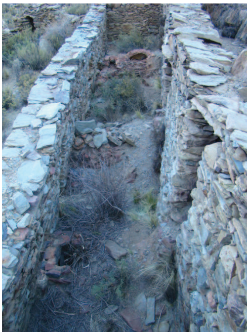
Figura 2: Vista del recinto que alberga tres hornos de reverbero (de arriba hacia abajo, hornos 1 a 3).
