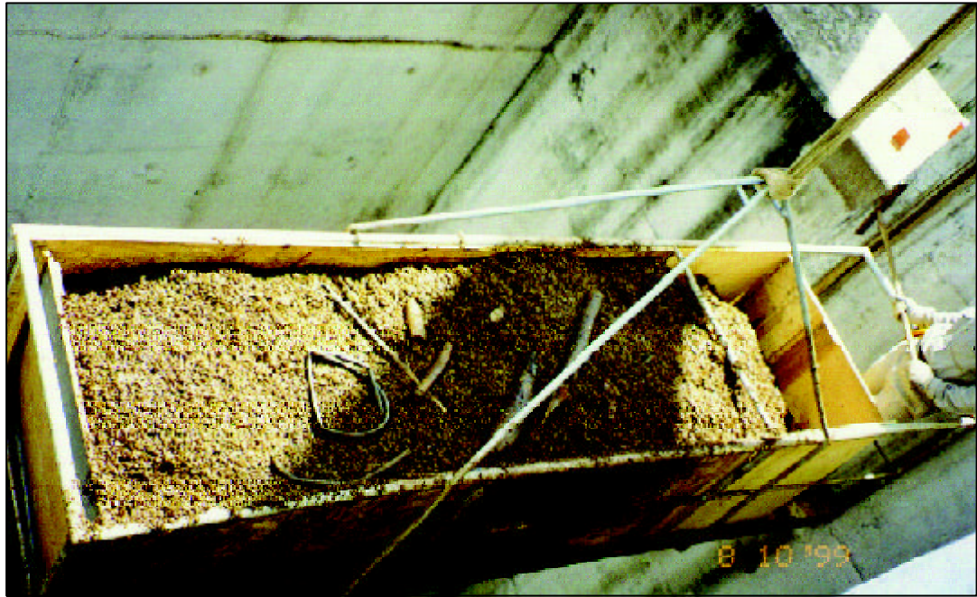
FIGURA 4: contenedor cargado con el mitilido invasor en el momento de ser subido para eliminar los ejemplares acumulados en la unidad 7 de la represa de Yacyretá (octubre 1999).
