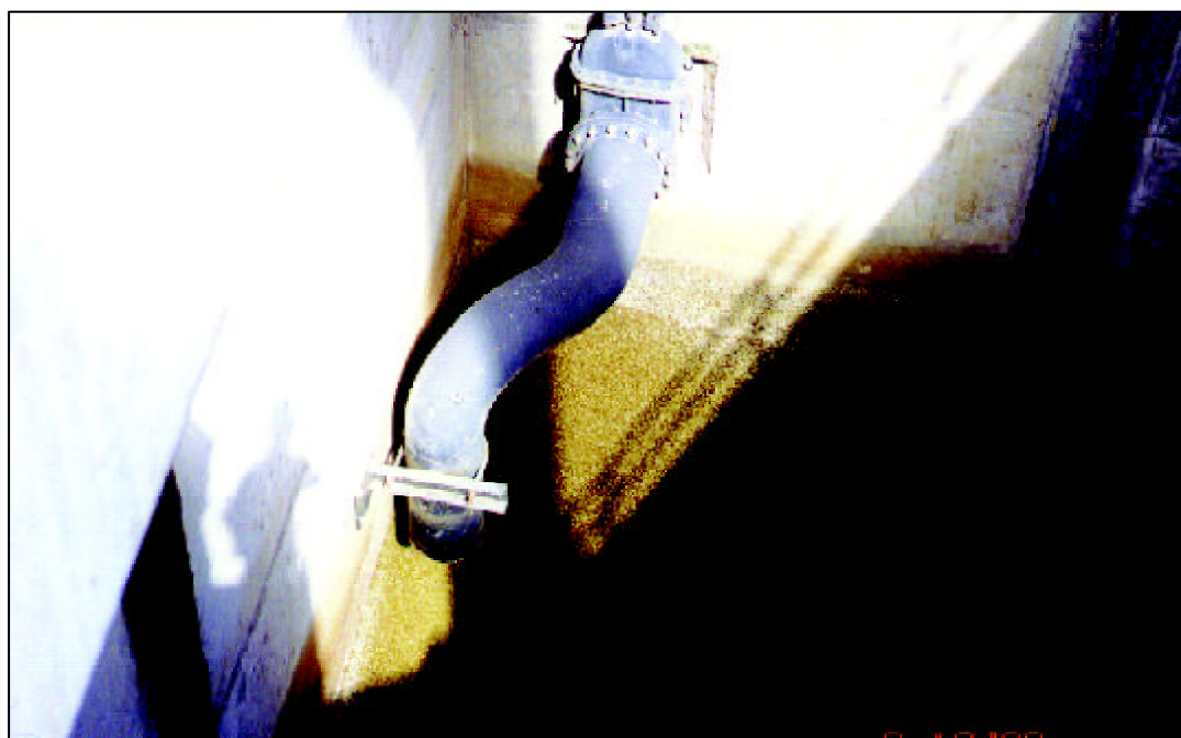
FIGURA 3: acúmulo de Limnosperma fortunei en la unidad 7 de la represa de Yacyretá en oportunidad de realizarse la limpieza destinada a la extracción de los ejemplares (octubre 1999)
